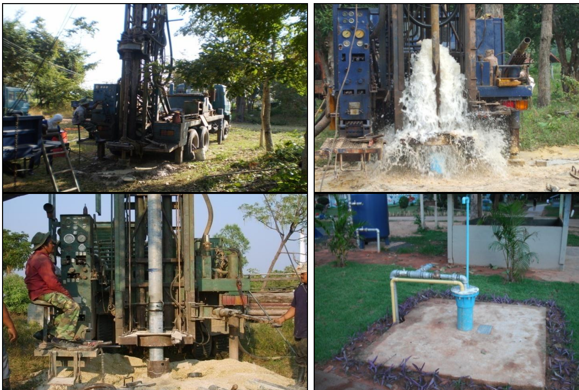
ภาพที่ 2 การเจาะบ่อน้ำบาดาล
