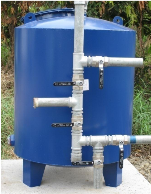
ภาพที่ 3-2 ถังกรองสนิมเหล็ก
